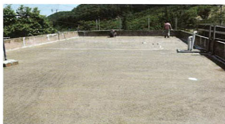
▲ 베다니동산 지붕 쿨루프 시공 전(좌) · 시공 후(우)
