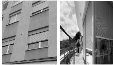
〔그림 11〕 단열셔터 설치 사례
