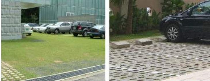
그림 2.5 주차장 투수성 포장 예시
