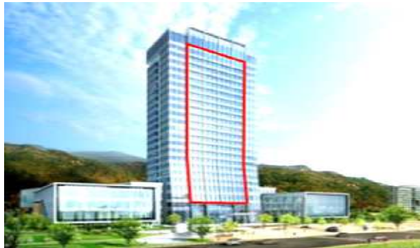
<BIPV 건물일체형 태양광 발전시스템>
